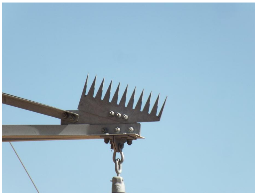
Figura 1. Dispositivo anti electrocución en la torre 552.
