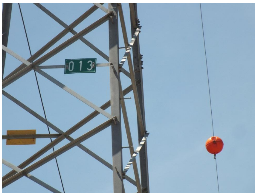
Figura 9. Detalle de baliza de señalización aeronáutica.
