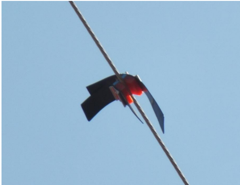
Figura 7. Detalle de dispositivo anti colisión de avifauna.
