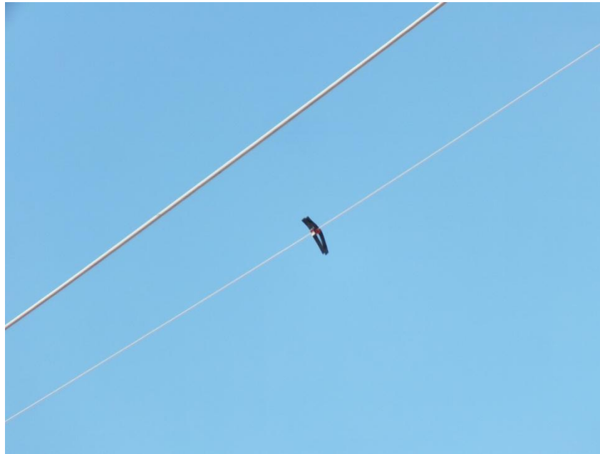
Figura 5. Dispositivo anticolidión entre las torres 6 y 7.
