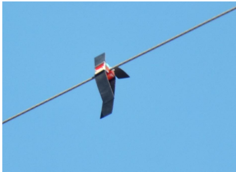
Figura 6. Detalle de dispositivo anti colisión de avifauna.
