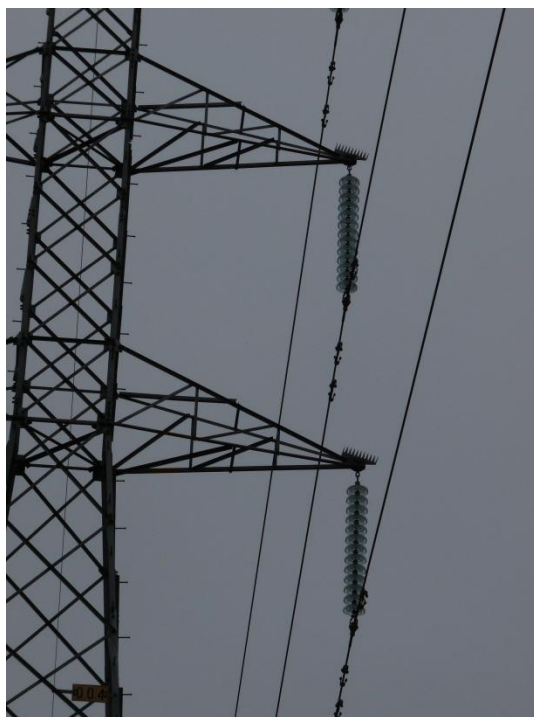
Figura 3. Disposición de los dispositivos antielectrocución en las torres.
