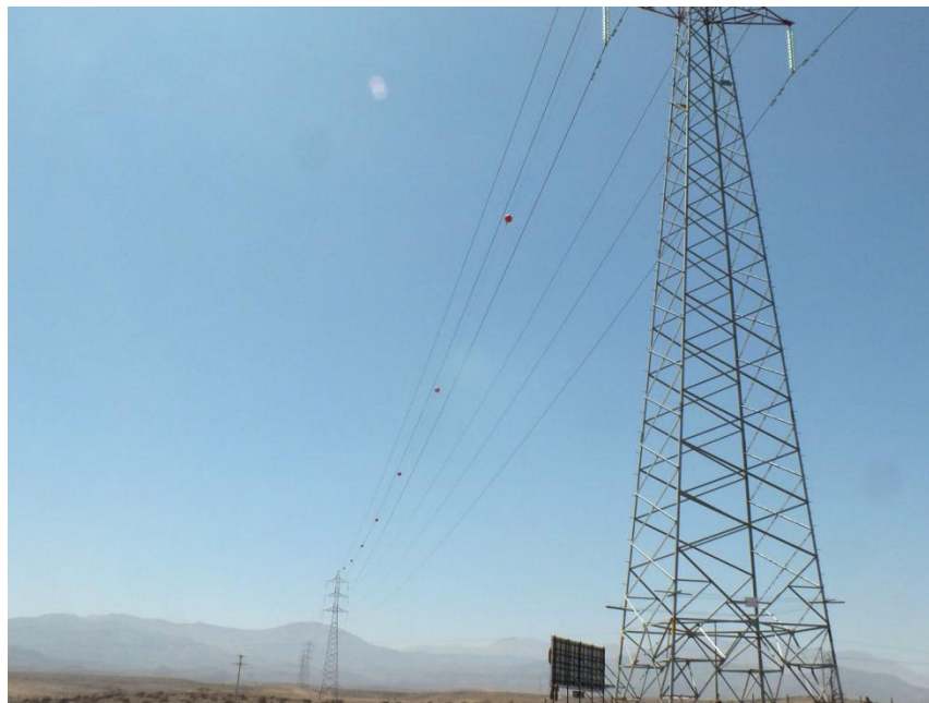
Figura 8. Cruce ruta 5 norte entre torres 64 y 65, con balizas de señalización aeronáutica.
