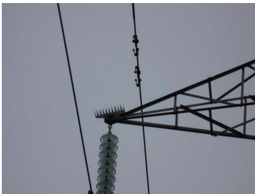
Figura 2. Dispositivo anticoliisión en la torre 480.
